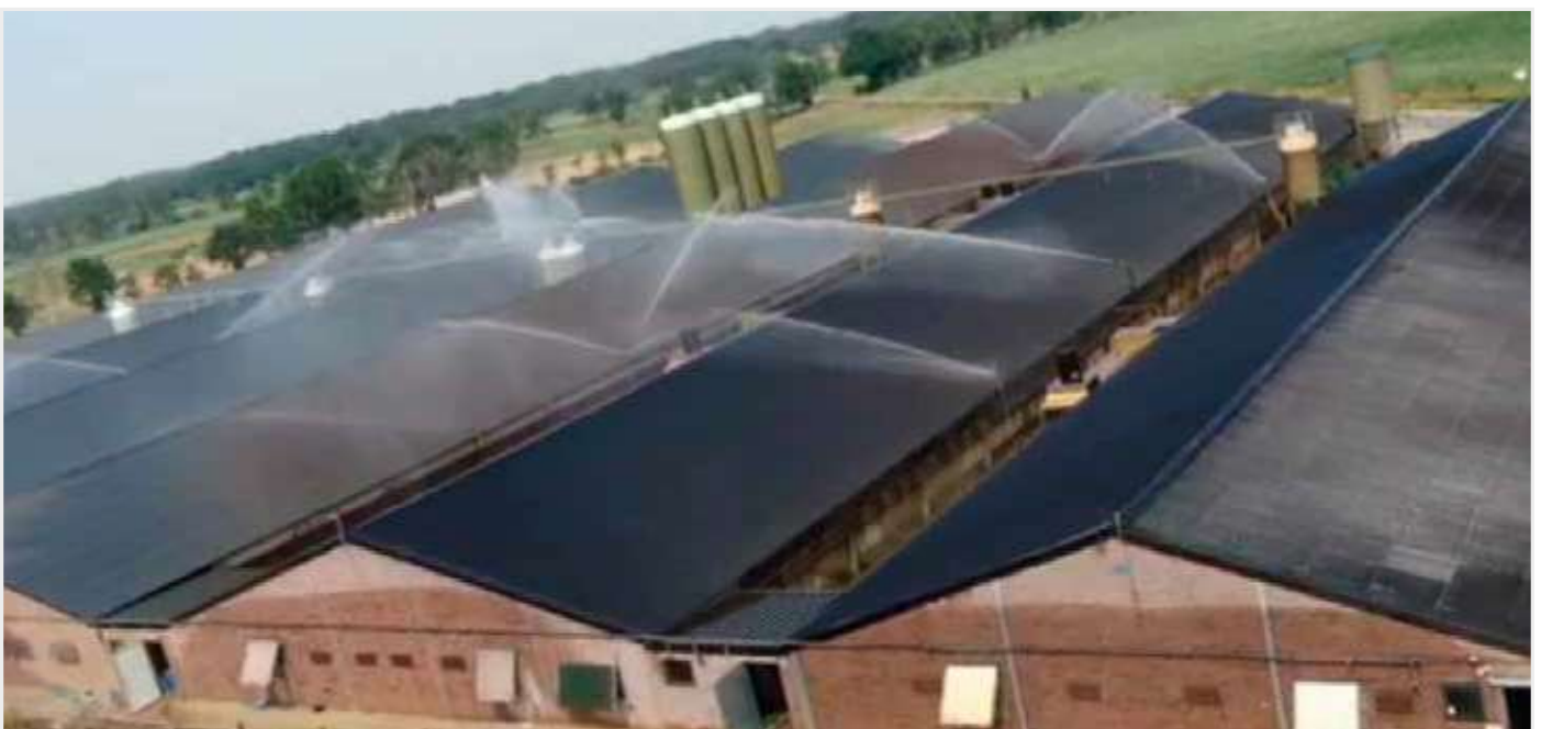
Bij extreme hitte koelt het bedrijf ook buiten door middel van sproeiers voor de inlaten en door regenwater over de stallen te sproeien en een nevelwolk te creëren.
